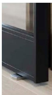
Pivotband bei 90° Öffnung
