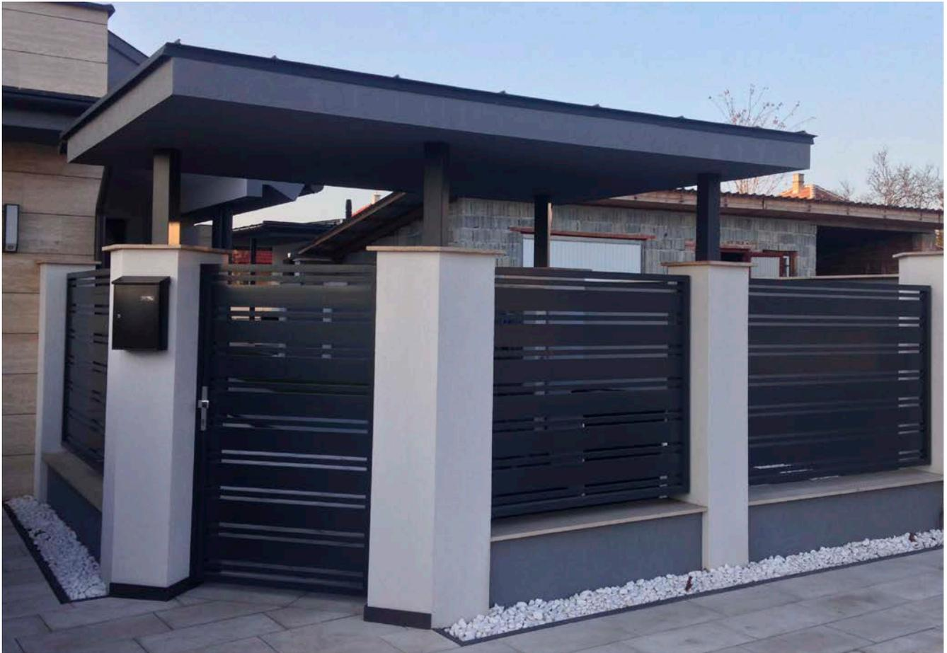
Die Füllstäbe aus 120 x 20 mm und 20 x 20 mm werden wechselseitig verbaut.
